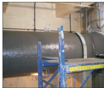
DuraWrap Primer applied.
