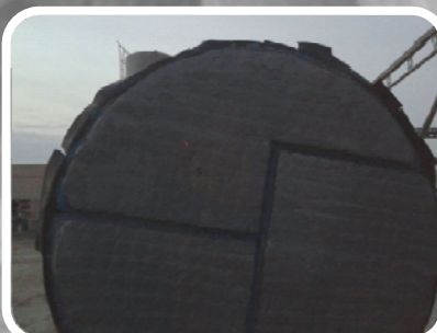
3. Reconstrucción de placas tubulares con METALCLAD CeramAlloy CP +(AC)
