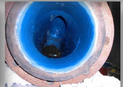
2. Aplicación de METALCLAD CeramAlloy CL+ (AC)
