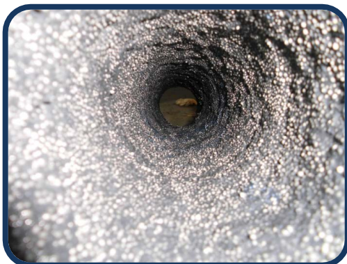
3. Aplicación de METALCLAD CeramAlloy CBX
