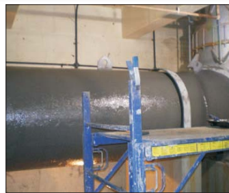
DuraWrap Primer applied.
